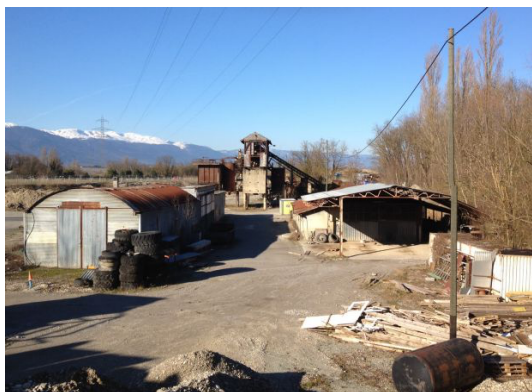
Site de la Petite Grave avant démolition (Photo: Héloïse Candolfi)
